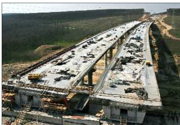
S70-es Völgyhíd építése M7-es autópályán
