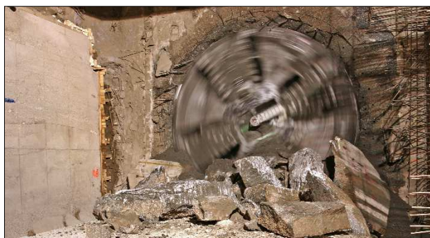
Metró fúrópajzs megérkezése a Bocskai úti állomásba
