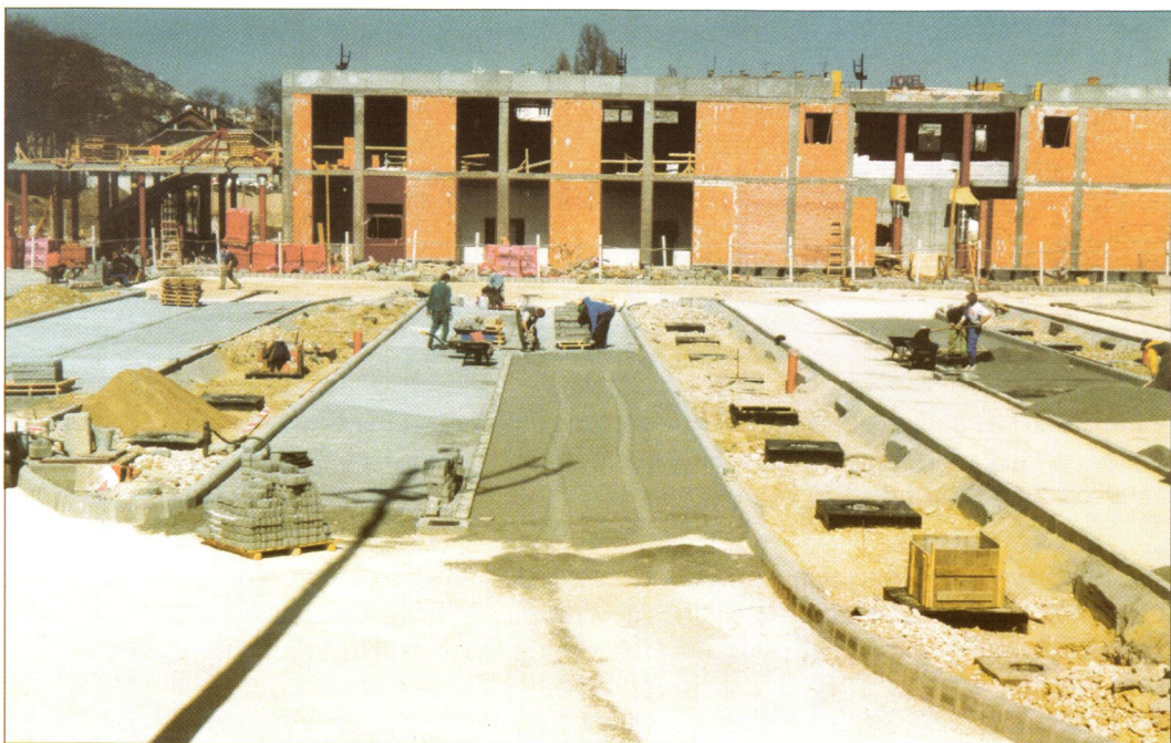
Fektető zúzalék terítése beton térkő alá a VOLÁN pályaudvaron
