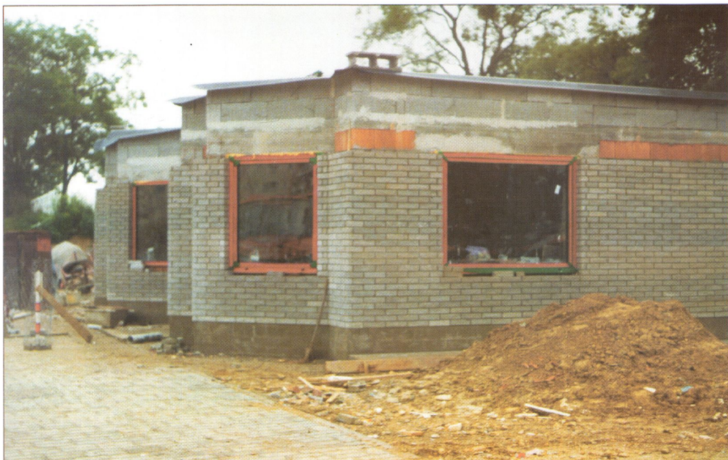
A BKV autóbusz végállomás épülő forgalmi épülete
