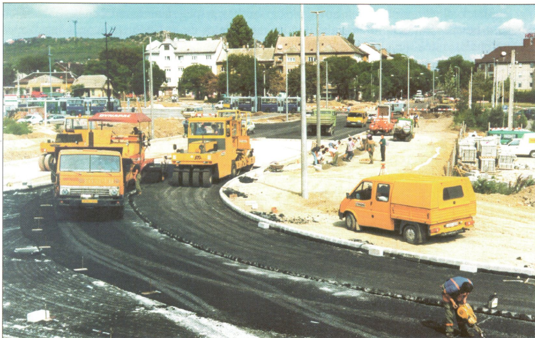
Aszfaltburkolat építése a Somogyi úton, a VOLÁN pályaudvar bejáratánál
