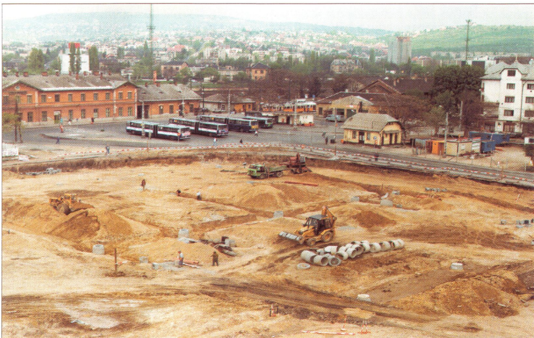
Csatornafektetés a tervezett BKV autóbusz végállomás helyén
